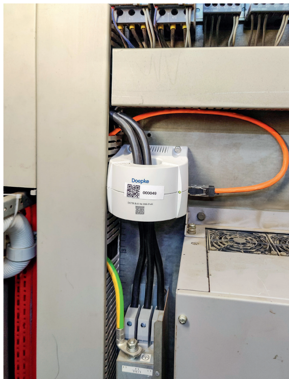
Einbausituationen der Differenzstrommonitore: Links im Schaltschrank und rechts in einem separatem Industriegehäuse
