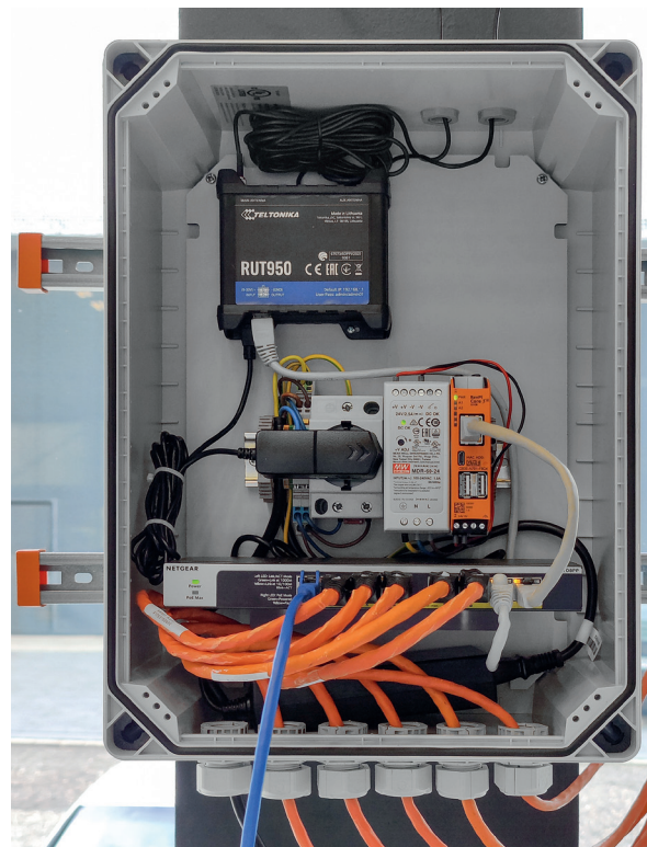
Einbausituationen der Differenzstrommonitore: Links im Schaltschrank und rechts in einem separatem Industriegehäuse
